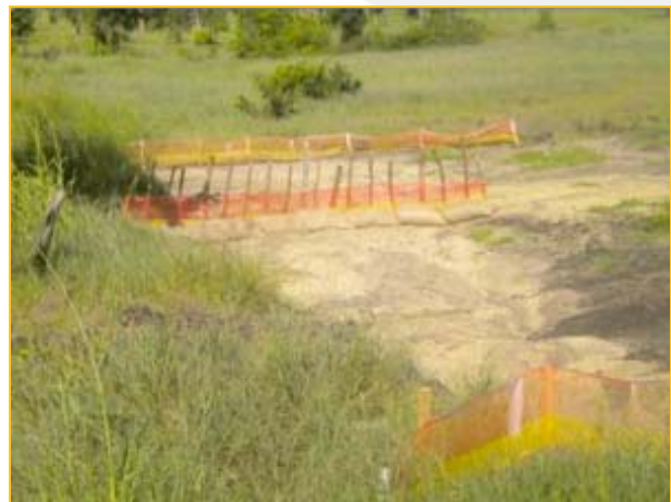
Plate 12.7: Sediment control, LNG plant site
