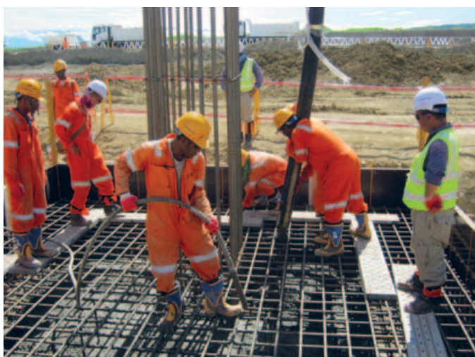
Plate 2.6 – First concrete foundation pour at the LNG plant site
