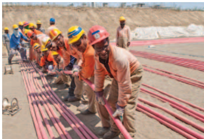
Plate 2.4 – Cable pulling at the LNG plant site
