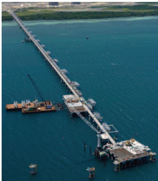
All 120 pipe rack modules now installed on the LNG jetty
