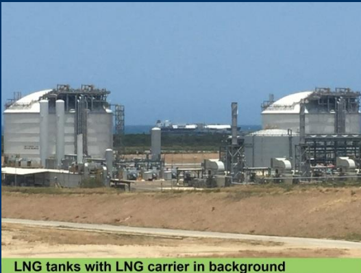
LNG tanks with LNG carrier in background
