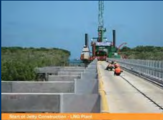
Start of Jetty Construction - LNG Plant
