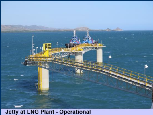
Jetty at LNG Plant - Operational
